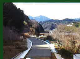
道路改良工事
