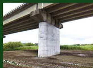
橋梁補強工事
