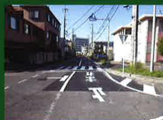
公共下水道工事
