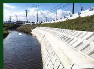
河川改修工事
